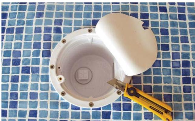
5. Puis, après avoir collé le 2ème joint sur la bride, positionnez-la et vissez ces 2 vis fermement à la main (pas de visseuse électrique) et avec un cutter, découpez l'intérieur.
