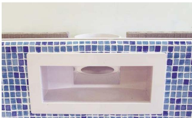
5. Avec un cutter, découpez le liner qui est à l'intérieur de la bride et posez le cache bride. L'étanchéité est réalisée. Le passage d'eau peut se faire.
