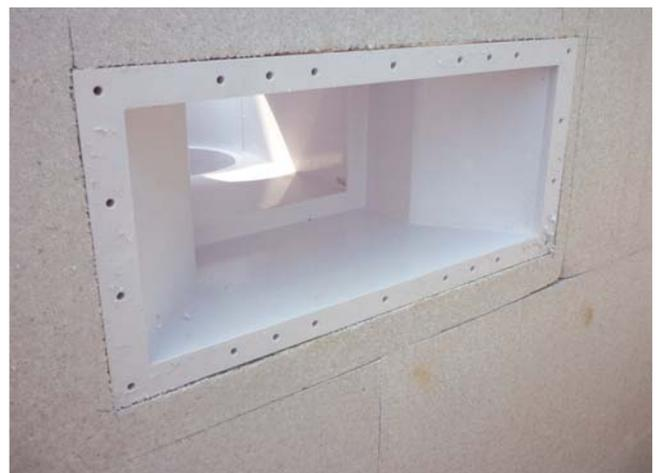
4. Le plan de joint du skimmer vient à fleur du mur et doit être parfaitement d'aplomb.
