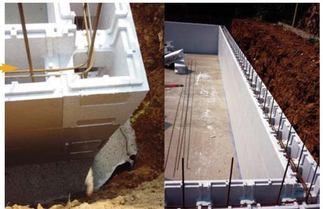
Partie à découper pour le passage des fers à béton et du béton
