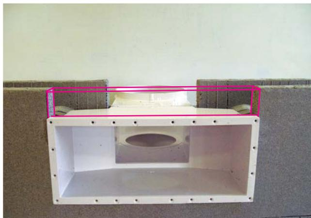
2. Placez le skimmer et veillez à ce qu'il soit bien plaqué contre le bloc, surtout pendant le coulage du béton. Remettez une pièce de polystyrène à cet endroit (entourage rose). N'oubliez pas de placer un ruban adhésif de protection sur les trous.
