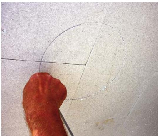
1. Positionner le centre du projecteur à 60 cm maximum du haut du mur. Tracer un cercle de 262 mm et couper à l'aide d'une lame de scie à métaux
