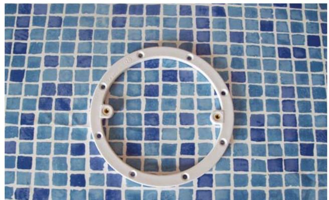
4. Lorsque le liner est posé et qu'il y a environ 5cm d'eau dans la piscine (pas moins), repérez au travers le liner par une pression du bout de l'index un premier trou et le second opposé.
