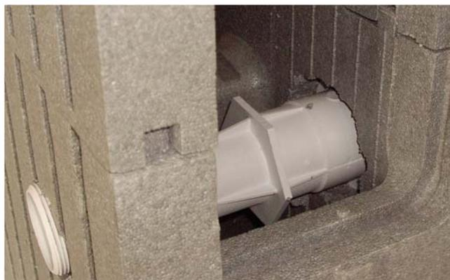
4. Enfoncez la traversée de paroi jusqu'en butée. Placez l'écrou.
