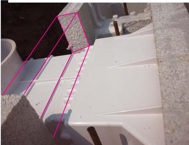
3. Couper le bloc côté remblai à la largeur de la rallonge du skimmer de sorte à le positionner parfaitement de niveau, puis refermer avec une chute de polystyrène bien calée.
