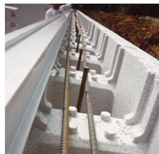
Détail bloc et ferrailage du rang supérieur
