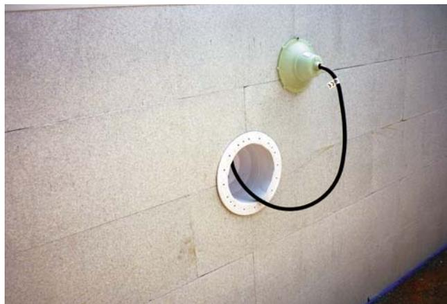
3. Après avoir posé le passe câble bien étanché sur la niche et passé celui-ci à l'arrière du bloc, poser le projecteur bien à plat sur la paroi. Vous pouvez laisser l'optique dans la niche (sans l'ampoule ni l'enjoliveur pour ne pas les salir) en la bloquant avec du scotch ou la fixer entre 2 blocs avec une simple vis (qu'il faudra retirer ensuite !)
